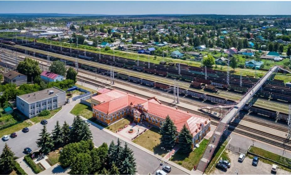
Ж/д станция «Инза» расположена на двухпутном участке «Кустарёвка — Самара» Куйбышевской железной дороги с электротягой постоянного тока (3 кВ).
